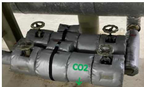
Kondensatgruppe vor und nach dem Isolieren
